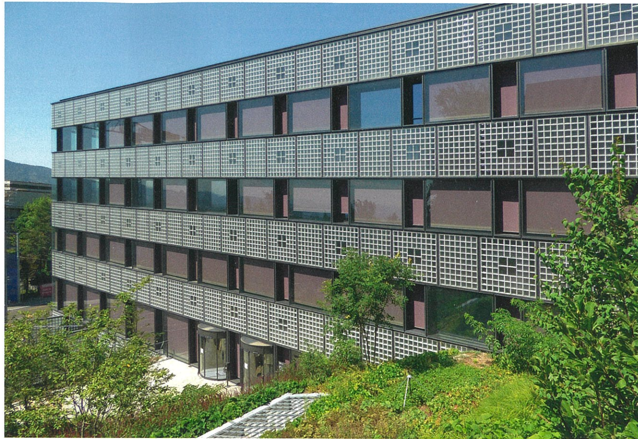
Die markante Doppelfassade des GLC. Im Bereich der zurückversetzten Lüftungsflügel ist die Fassade einschichtig.
