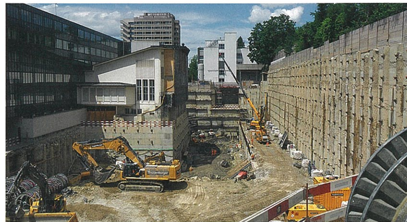
Die Baugrube mit ausgefachter Bohrpfahlwand und dem unterfangenen Paul-Scherrer-Hörsaal.
